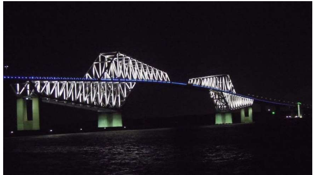
東京ゲートブリッジ(4月2日)
